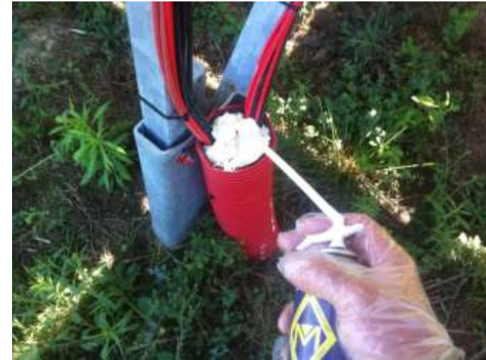
Προστασία σπιδράλ από νερά
