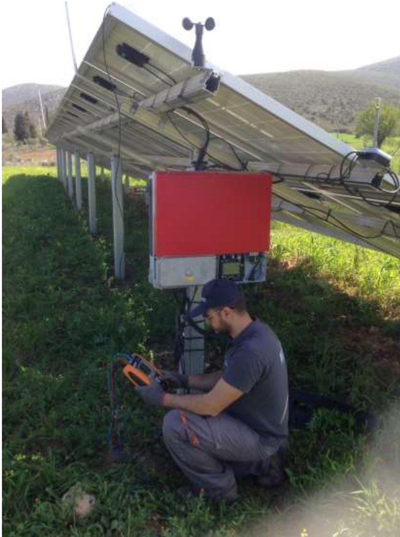
ΜΕΤΡΗΣΗ ΠΟΣΟΣΤΟΥ ΠΤΩΣΗΣ ΑΠΟΔΟΣΗΣ STRING ή PANEL
